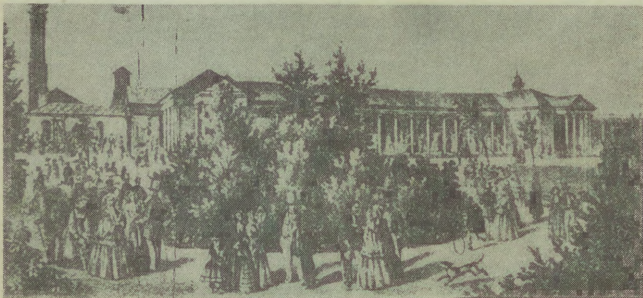
Stara galeria spacerowa: po lewej stronie maszynownia i źródło Nr 3. Rok 1851.
