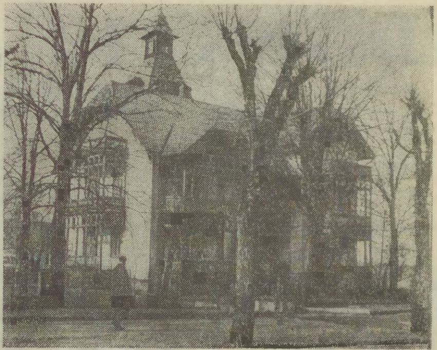
Budynek przy ul. Warzelniańskiej 5 przez okres ponad 10 lat siedziba zarządu Oddziału PTTK i dom wycieczkowy do 1973 r. Budynek rozebrany w 1985 roku.
