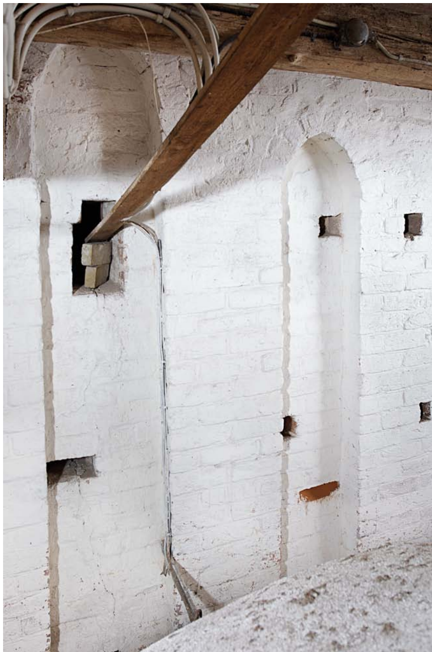
Fig. 9. Udsnit af vestgavlens blændingsudsmykning (s. 2735). Foto Arnold Mikkelsen 2012. – Part of recess ornamentation of west gable.
