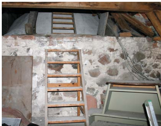
Fig. 31. Kampestensmurværk over våbenhusets loft (s. 2734). Foto Martin Wangsgaard Jürgensen 2012. – Fieldstone masonry above porch ceiling.
