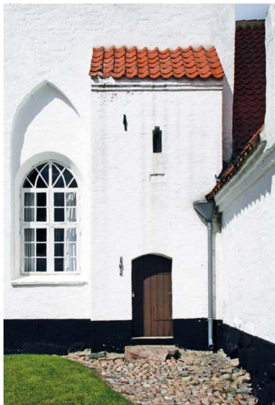
Fig. 7. Trappehuset set fra syd (s. 2737). Foto Martin Wangsgaard Jürgensen 2012. – Stairwell seen from the south.
