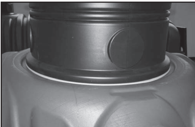
FIG.4 Install Riser
