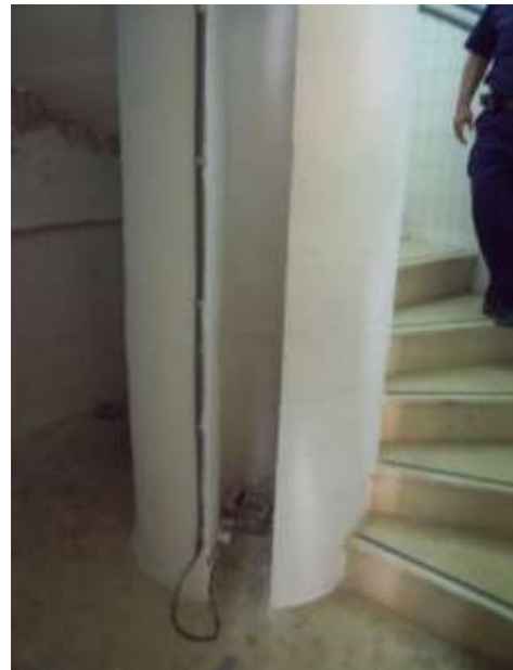
Figura 6. Mecanismo de relojería para faros (izda. Faro de Punta Almina) y canalón central para el recorrido de las pesas (dcha. Faro de Sacratif).
