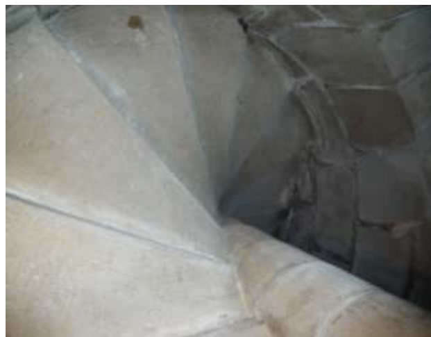
Figura 15. Detalle de la escalera de la Torre del Faro de Higer
