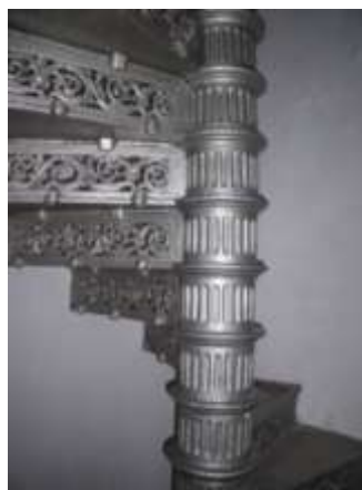
Figura 30. Escalera de caracol íntegramente en fundición (Faro de la Isla de Santa Clara).
