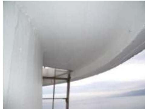
Figura 33. Conexión entre la cámara de servicio y la de iluminación (izda.). A la derecha se observa un acceso, por el exterior, desde la cámara de servicio al exterior de la linterna (Faro de Guetaria).
