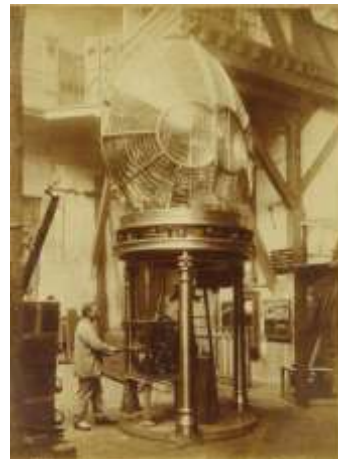
Fotografía del montaje de la óptica, mecanismo de giro y basamento en los talleres de la firma Henry Lépaute (anterior a 1918)
