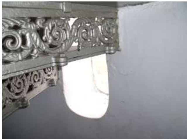
Figura 14. Detalle de la escalera de la Torre del Faro de Guetaria
