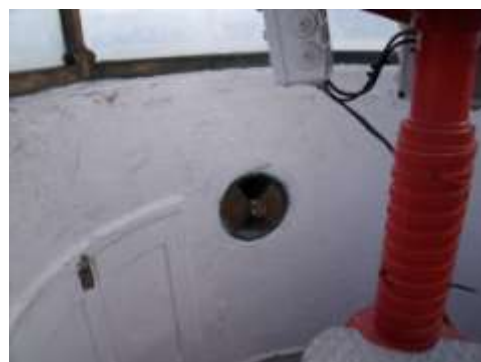
Figura 32. Cámara de iluminación y trampilla de acceso al exterior en la baliza de la Isla de Santa Clara (en la parte inferior de la imagen de la derecha).
