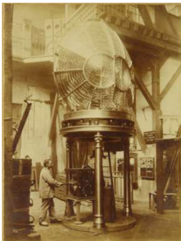
Figura 36. Pruebas de la óptica, mecanismo de giro y basamento en los talleres de la empresa “H. Lépaute” para el Faro de Punta Almira (Ceuta). La fecha exacta es desconocida pero en todo caso es anterior a 1917 (Fuente: Archivo Francisco Climent, fondo La Maquinista Valenciana).
