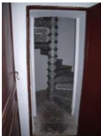
Figura 30. Escalera de caracol íntegramente en fundición (Faro de la Isla de Santa Clara).
