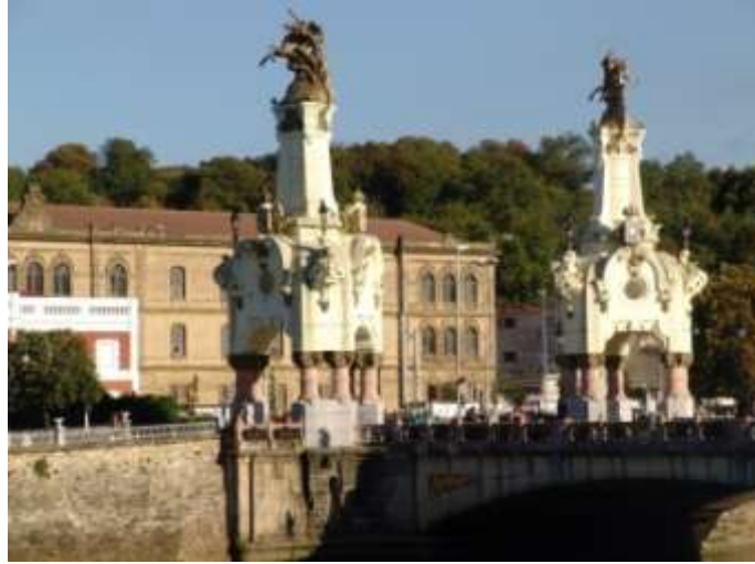
Figura 16. Fachada del edificio de Tabacalera (Donostia-San Sebastián)
