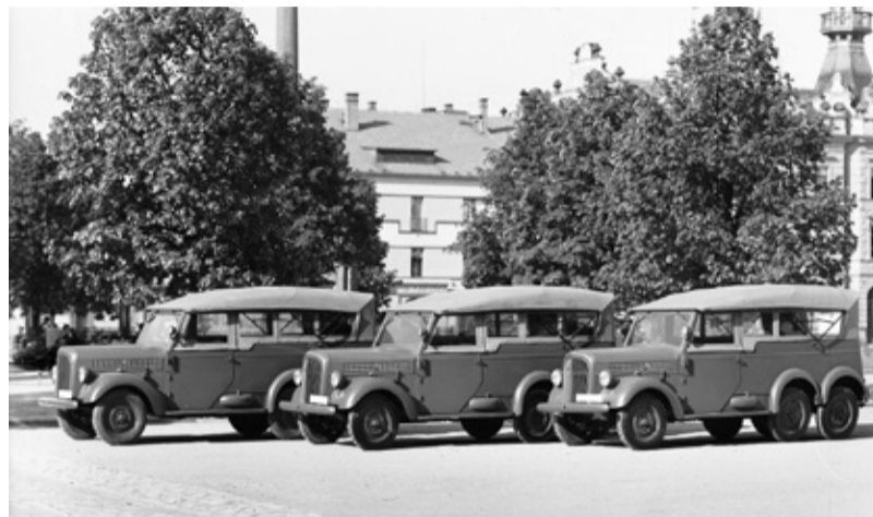
V květnu 1943 byly u Sodomky zhotoveny tři velitelské vozy pro chorvatské vzdušné síly na podvozku Škoda 903. Foto: Jan Popelka, (RMVM).
