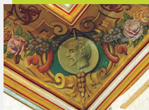
Détail de la corniche d'un plafond peint. Cliché : 2006.
