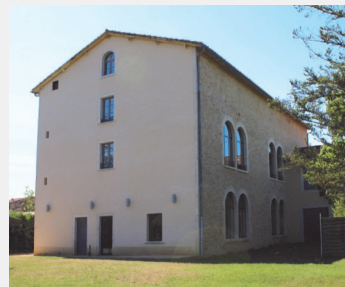
Elévation nord. Les baies géminées qui se distinguent par leur forme et leur taille rendent compte de la fonction première de l'édifice : une école d'art.
