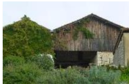
Grange dans le centre d'Ordan
