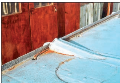
6. ábra. Az elevátor korszakban behelyezett merevítő gerendák egyike, amint a felszínre bukkan
