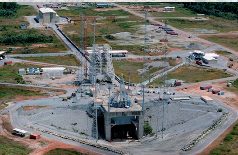
9. ábra. A lángterelőakna 140 méter széles és 123 méter hosszú (ESA)
