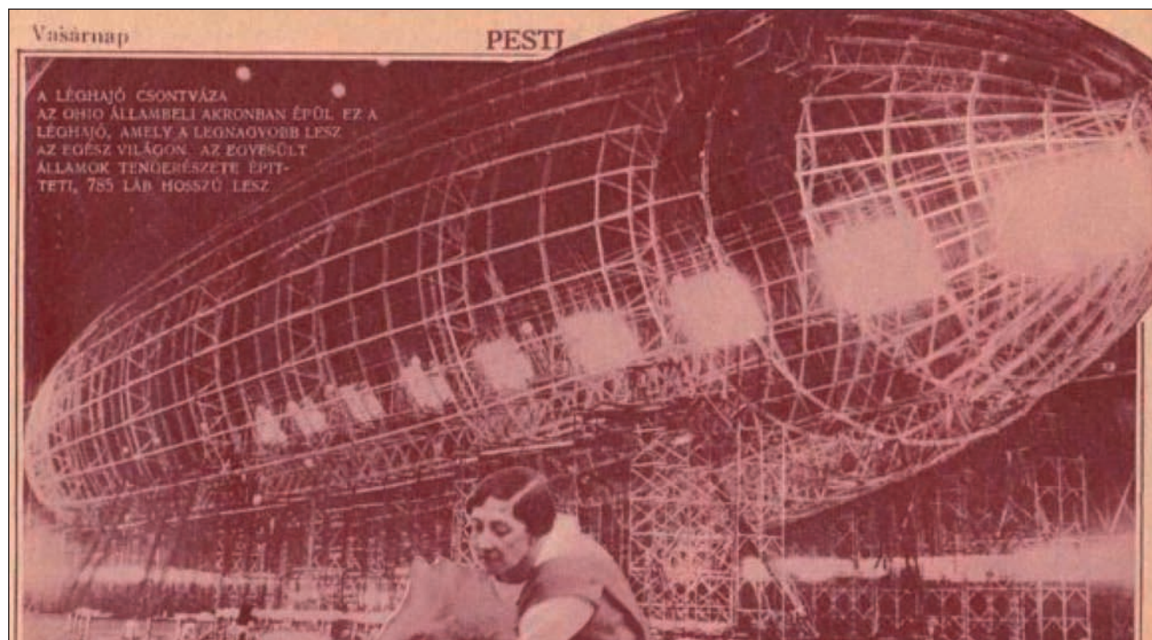
1. ábra. Az USN 239 m hosszú épülő léghajójának váza Akronban, a háború után. A ráccstartó a Zeppelin rendszer erősített változata volt
