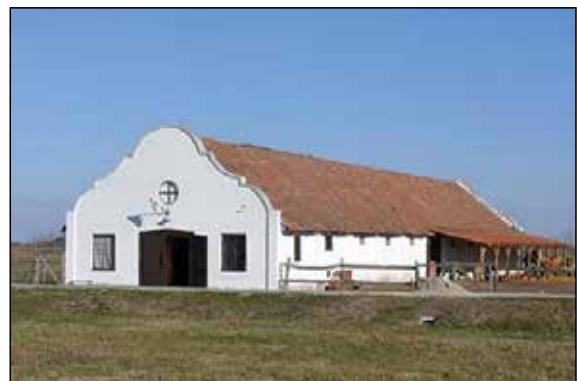
Tiszanána: egy példásan felújított istálló (2018. november)
