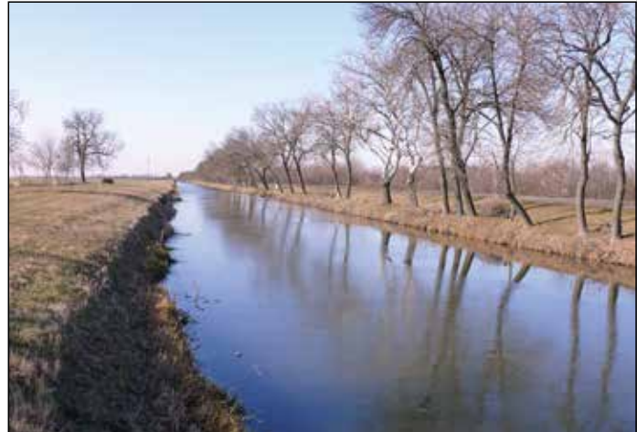
Kisújszállás–Márialaka: az 1930-as években épített belvízlevezető csatorna (2020. február)
