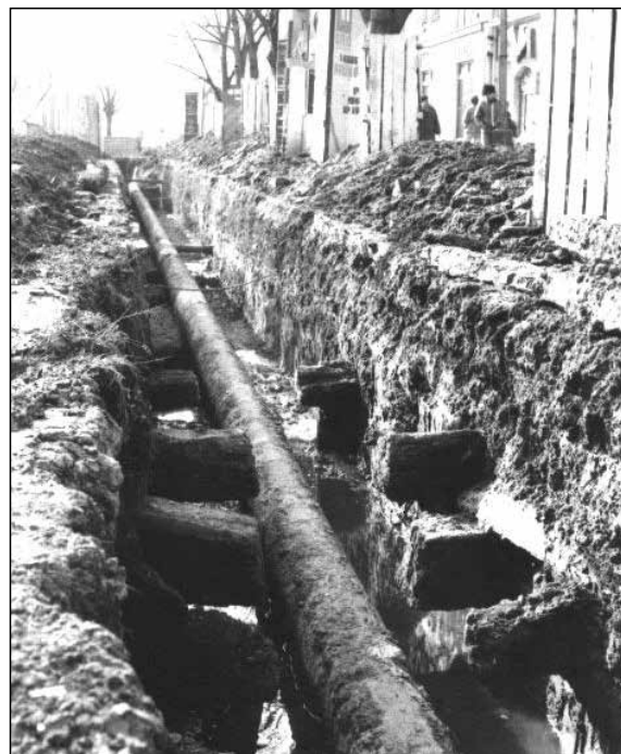
Debrecen: a 19. sz. közepéig sáros időszakban a főutcán a közlekedést egy ún. Nagyhid segítette. Ennek gerendáit tartta fel egy vezetékipítés 1984-ben.
