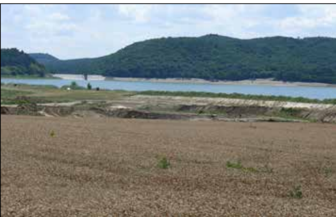
Fehérvárcsurgó: völgyzárógát és a Csurgói-tó (2019. július)
