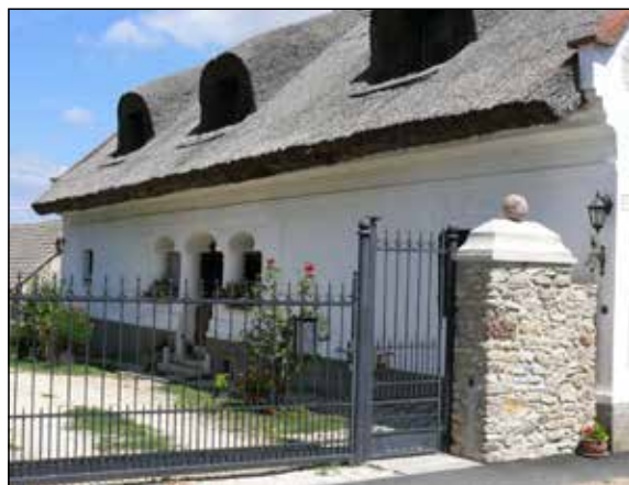
Vöröstó: jellegzetes bakonyi – balatonfelvidéki építési stílus, amelyet több környékbeli településen sikerült faluképet meghatározó mértékben megőrizni (2016. július)
