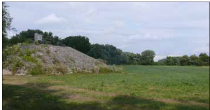
Kisbajcs–Szögye: vízműkút az ártéren. A Szigetköz alatt van az ország egyik legjelentősebb felszín alatti vízbázisa, aminek sérülékenysége kulcsszerepet játszott a Bős-nagymarosi vízerőmű tervek és építkezések szakmai vitáiban. (2019. július).
