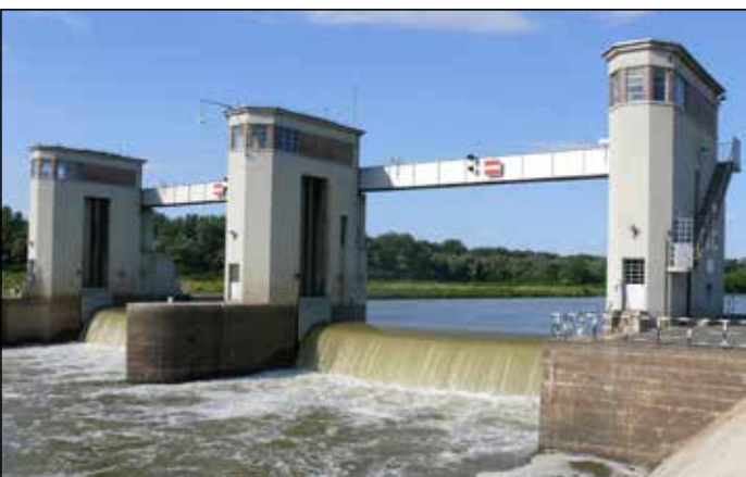
Békésszentandrás: vízlépcső és vízerőmű (épült 1936-1942 között) (2019. június)
