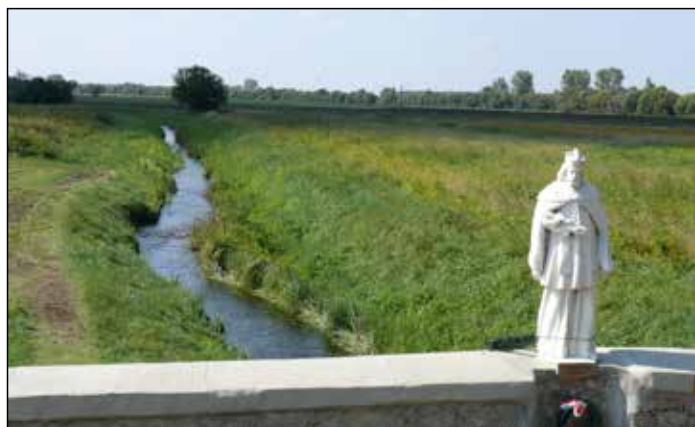
Káptalanfa: a Kigyós-patakon átvezető Szent János híd (2018. szeptember)
