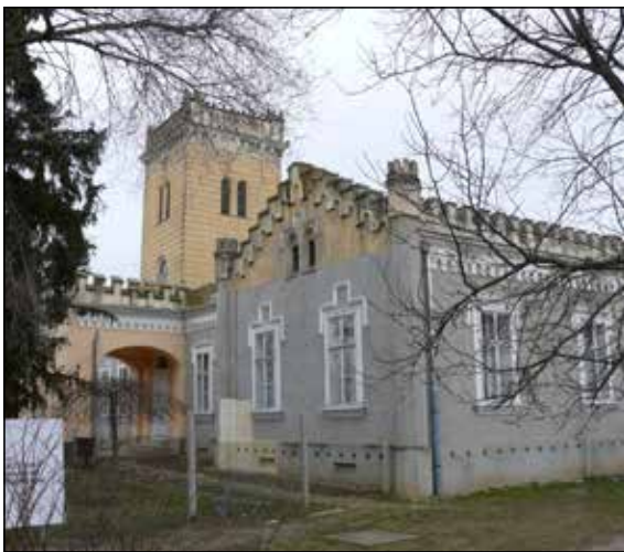
Zsáka: a tájra jellemző magas talajvízállás falakat átnevelő hatása ellen szellőztető kerámiaacsoveket építettek be a volt Rhédey-kastély lábáztatába (2019. február)
