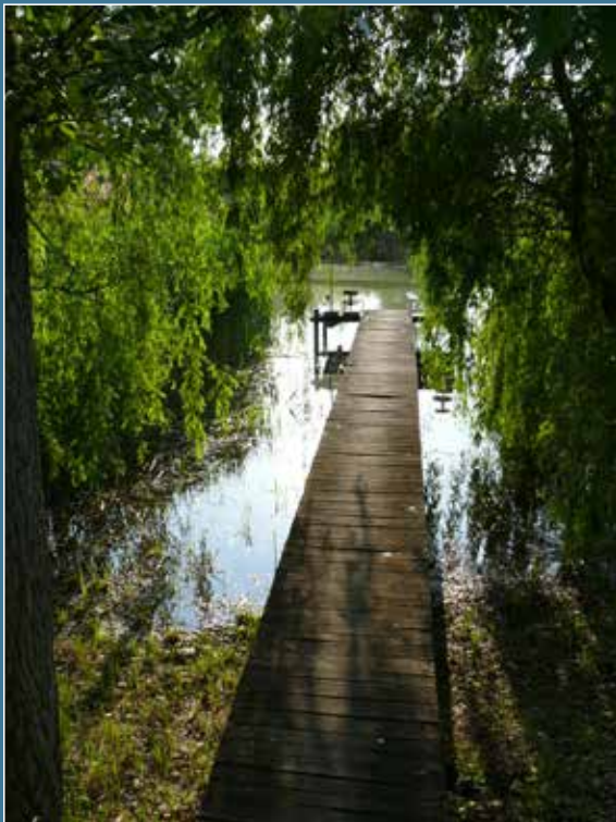
Hajdúböszörmény (Hajdúhát) Keleti-főcsatorna
