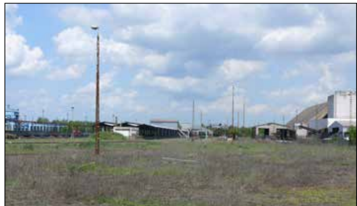
Eperjeske 1989-előtti nagy forgalmú vasúti átrakodó állomás volt (2019. május)
