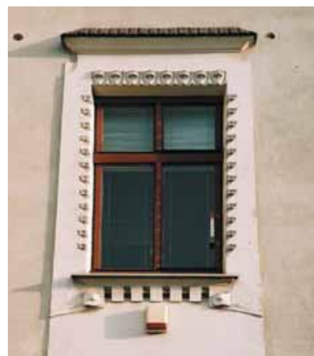
Wokół otworów okiennych piętra opaski w formie listew wyrobionych w tynku, od strony otworu z obramieniem z żabek
