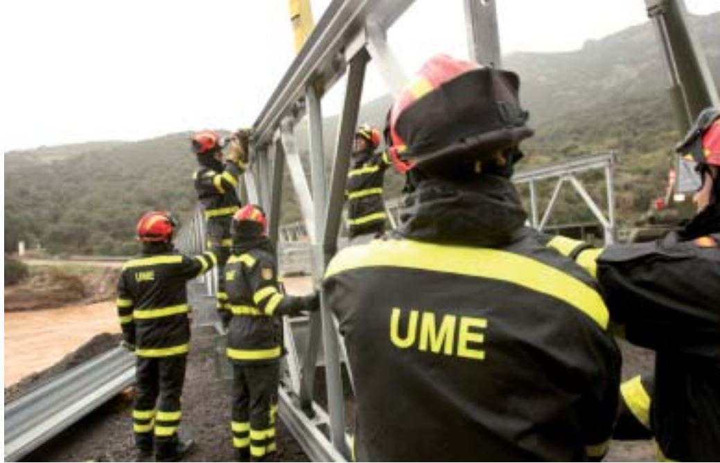
Miembros del Batallón de Intervención de Emergencias, con sede en Torrejón de Ardoz, trabajan en la instalación de un puente bailey en Mestanza (Ciudad Real)
