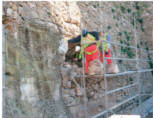
(figura 7) Recogida de materiales y desescombro del silo A (Foso del Hornabeque).
