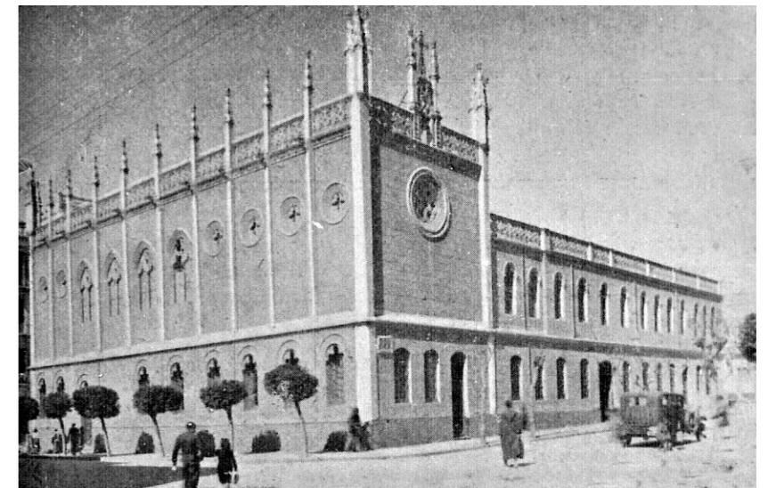
El colegio del Buen Consejo después de la intervención de Pérez Reina y antes de que se elevara la tercera planta. Foto del archivo de Antonio Bravo.
