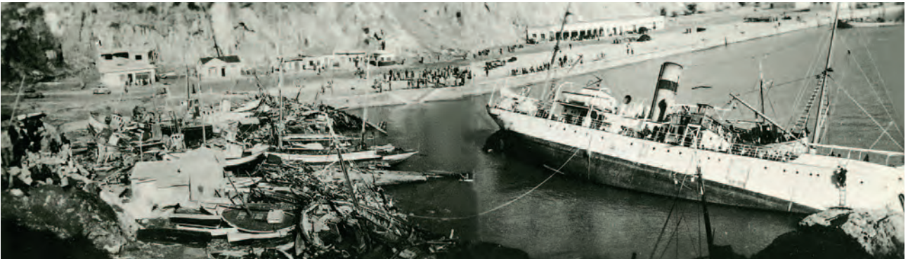
(Figura 9) Trabajos de puesta a flote del Correo "Fuerteventura" con la flota pesquera destrozada en el muelle de Villa Sanjurjo, ap. 1950.
