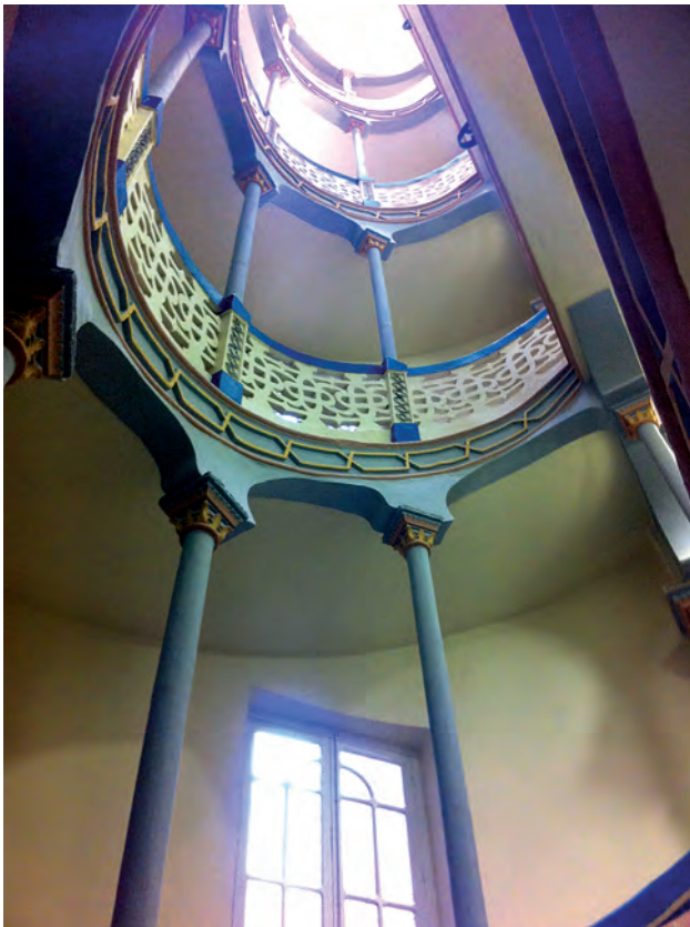
(Figura 10) Caja de escalera con el colorido anterior a la intervención.
