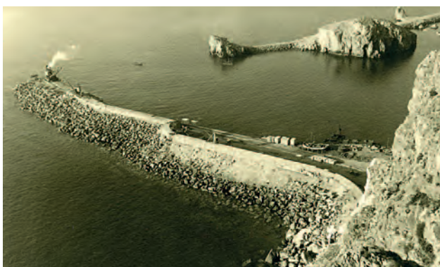
(Figura 11) El puerto de Villa Sanjurjo tras su reconstrucción, 15 de julio de 1954.
