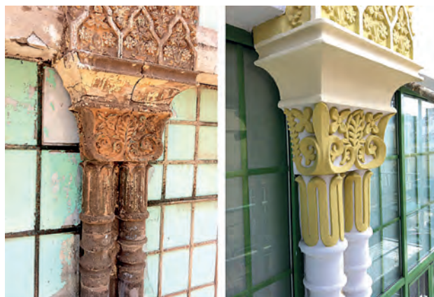
(Figura 7) Columnas y capiteles antes y después de la intervención.
