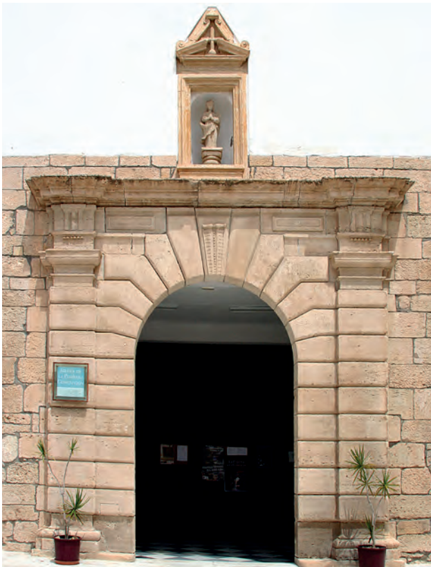
(Figura 3) Portada de piedra de diseño manierista en el ingreso a la iglesia parroquial (finales del siglo XVI).
