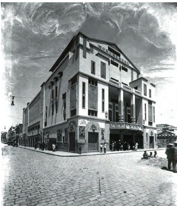
(Figura 6) El Teatro Monumental, uno de los mejores ejemplos del art déco en Melilla, inaugurado en 1931, actualmente remodelado como edificio de locales y oficinas. Archivo General de Melilla.
