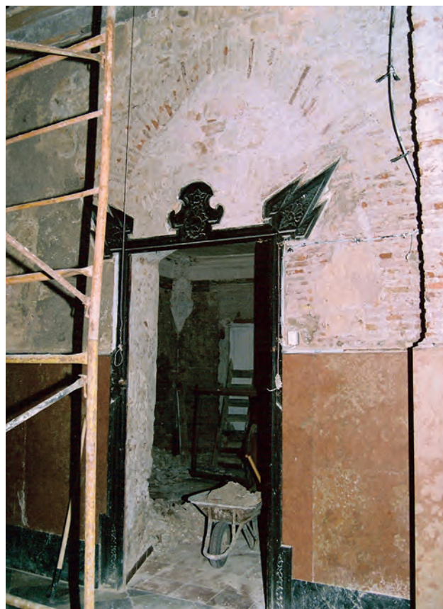
(Figura 1) Arco apuntado de configuración Gótica aparecido, en la actual capilla de Ánimas, durante las labores de restauración de 1992.
