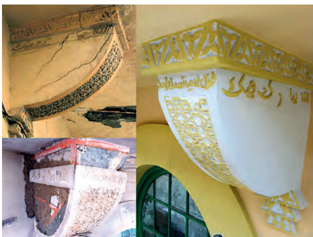
(Figura 6) Detalle de los trabajos de refuerzo en la zona de las ménsulas.
