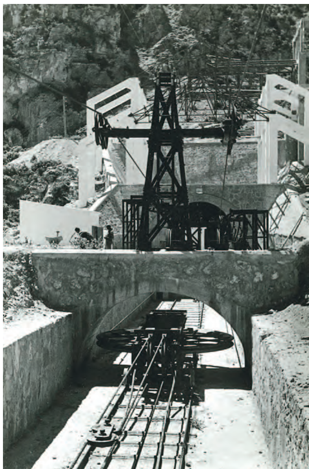
(Figura 2) Estación de carga del teleférico en la cantera de calizas de Tetuán. García Cortés, mayo 1953.
