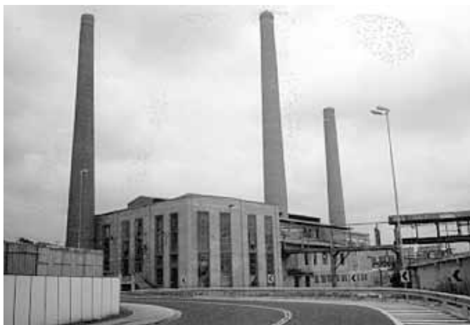
Foto 34 - Casa das Caldeiras
