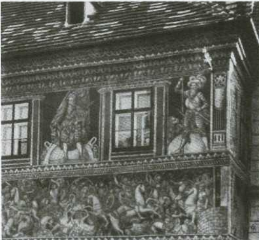
dom z renesansową dekoracją sgraffitową, Prachatice
