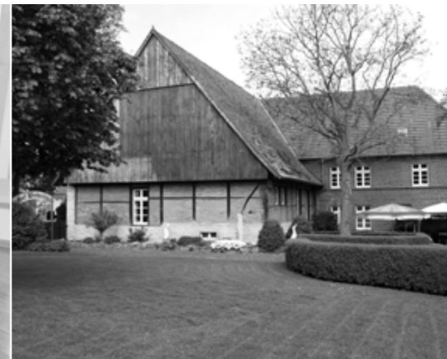
Rückansicht des Baumberger-Sandstein-Museums, das zum „Kompetenzzentrum für Naturstein und Baukultur“ entwickelt wird.
