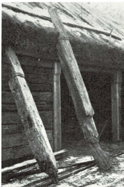
Bild 2. Portlidersstolparna i Kvekgården, som gå ned 1 m. under jordytan och upptill ha en klyka för timret.
