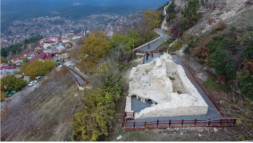
Fotoğraf 5: Hamamın Genel Görünümü ve Çamlıyayla İlçesi.
