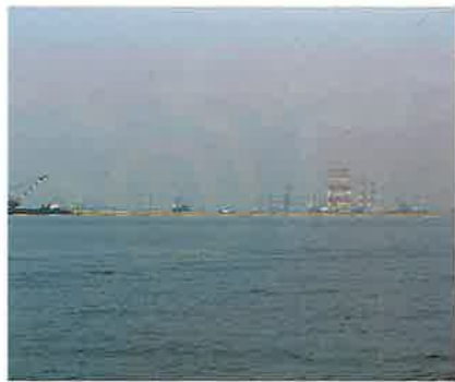
埋め立てが進む新空港建設現場
