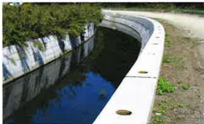
こんなコンクリートの小川にも生き物たちがいた
