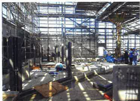
▲工事中の奇跡の森ゾーン
