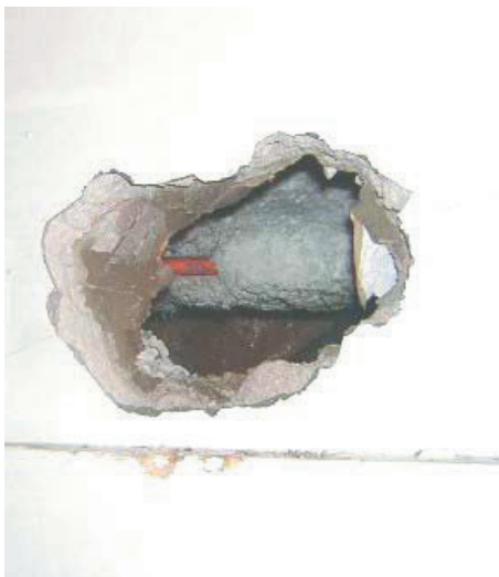
Obrázek 4.4: Trubka s azbestovou izolací v částečně odkryté zdi.
