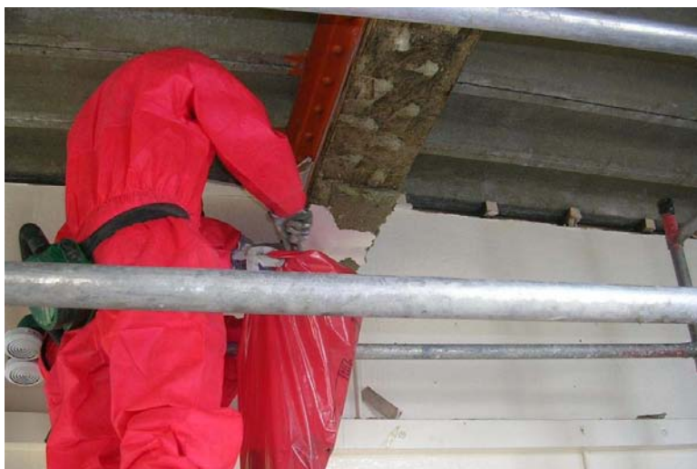
Obrázek 12.11: Pytlování odpadu blízko místa odstraňování azbestu, aby se zamezilo šíření kontaminace a minimalizovala expozice.
