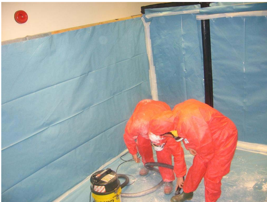
Obrázek 7.1: Praktický nácvik použití vysavače třídy H – odstraňování simulované kontaminace (mastkový prášek). Obrázek poskytl HSE Spojeného království.
