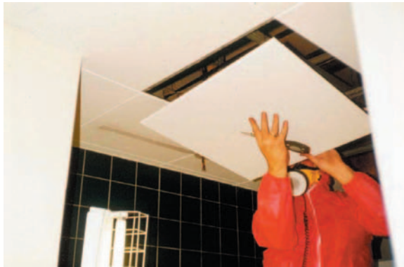
Obrázek 12.13: Opatrné odstranění azbestové stropní obkladové desky. Obrázek poskytl HSE Spojeného království.
