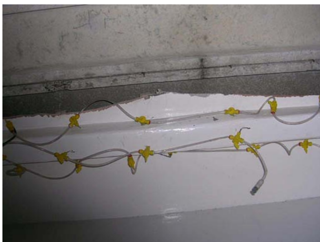
Obrázek 12.10: Příklad navlhčení stříkané azbestové izolace pomocí vícebodové injektáže.
