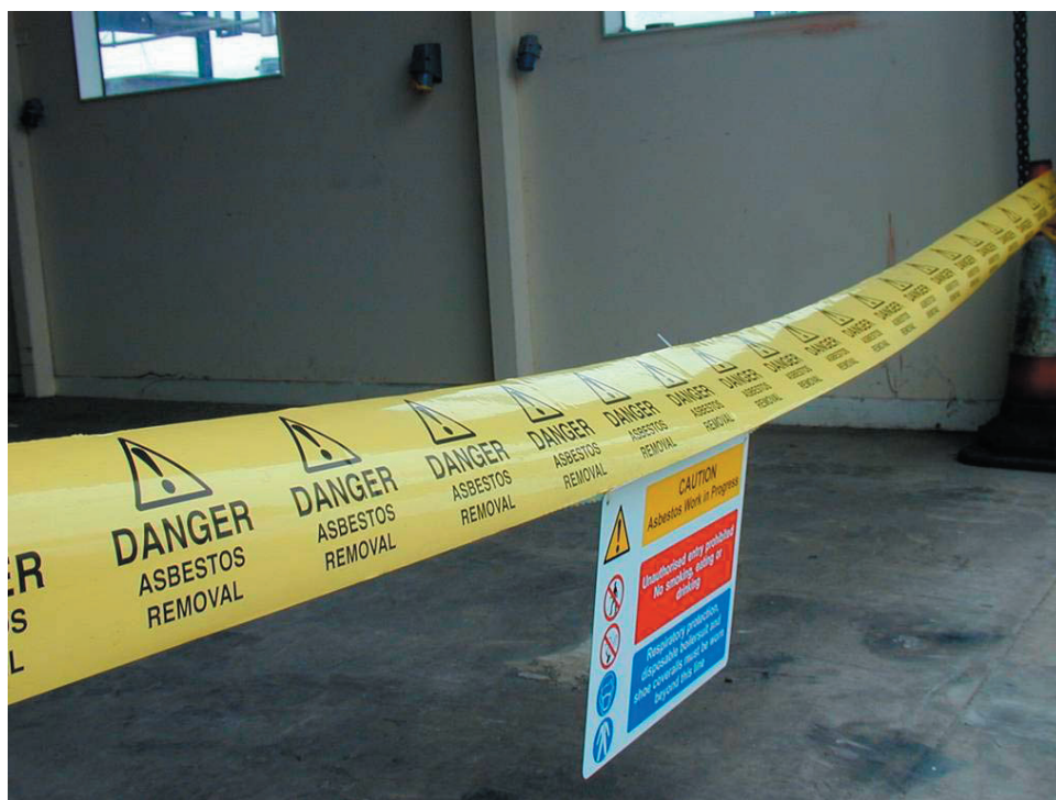
Obrázek 11.1: Oddělení pracovního prostoru pomocí výstražné pásky (s nápisy „Nebezpečí – odstraňování azbestu“) a výstražné tabule.
