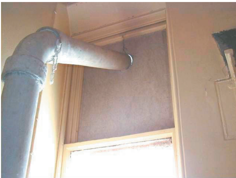
Obrázek 4.5: Azbestocementová kouřová trubka s těsněním z azbestových provazců, procházející azbestovým výplňovým panelem.
