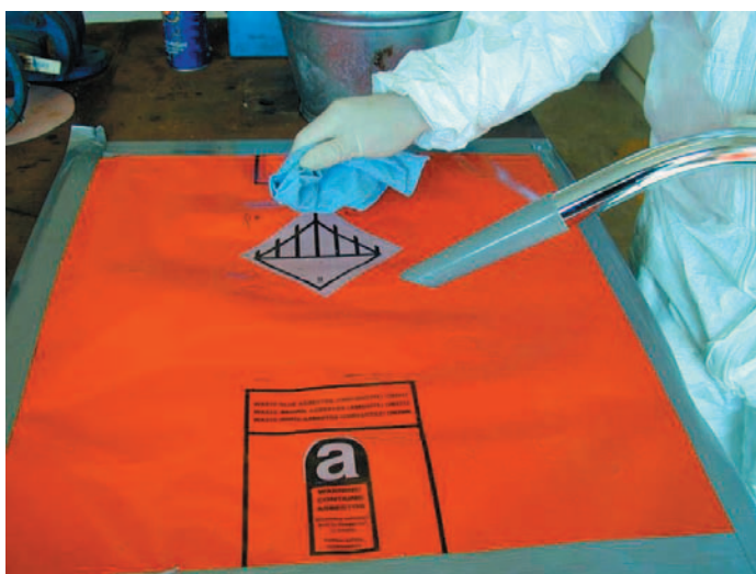
Obrázek 11.7: Pečlivé vyčištění pracovní plochy vysavačem třídy H a vlhkými utěrkami.
