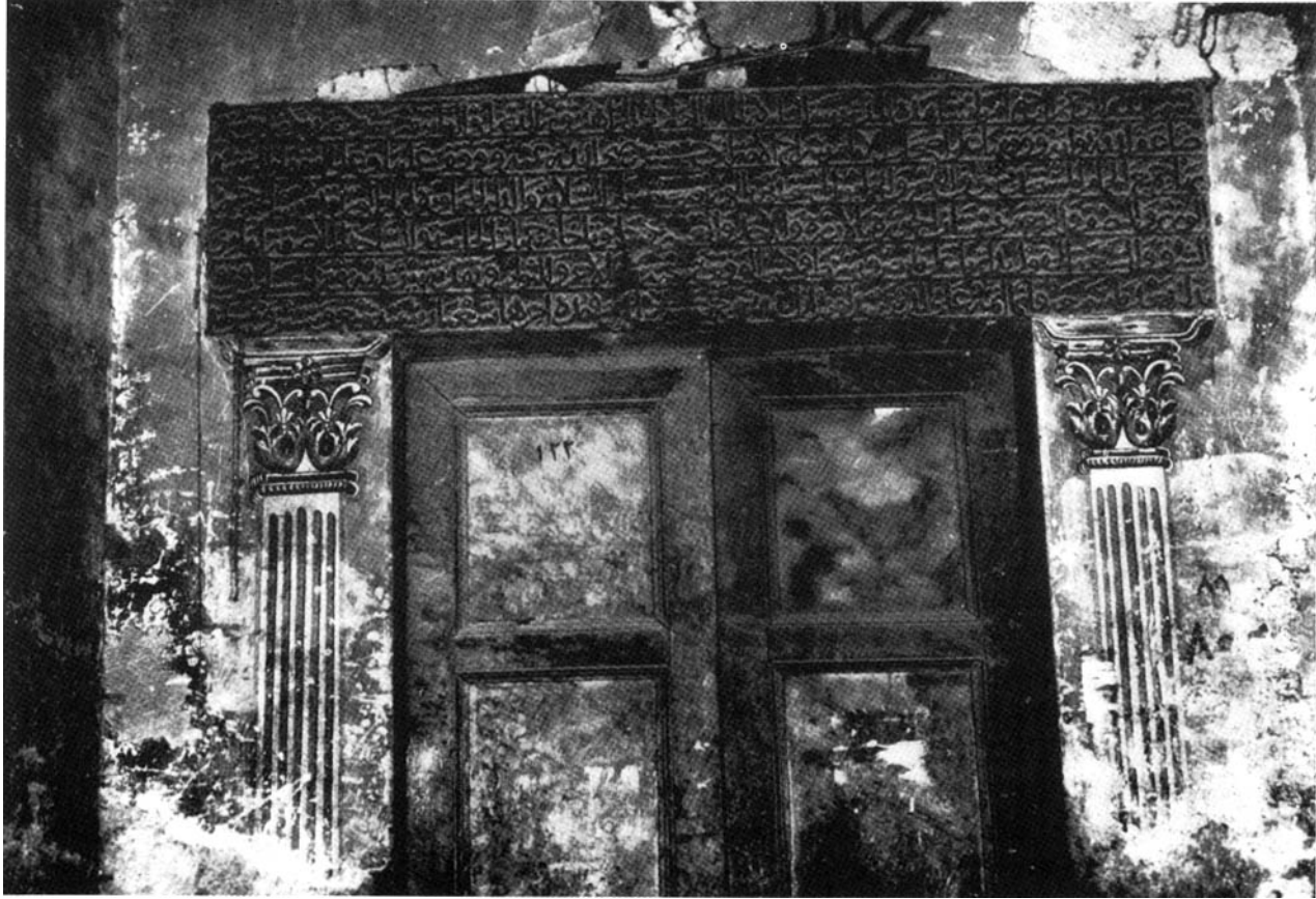
7. Madrasa al-Nūriyya, exterior façade
