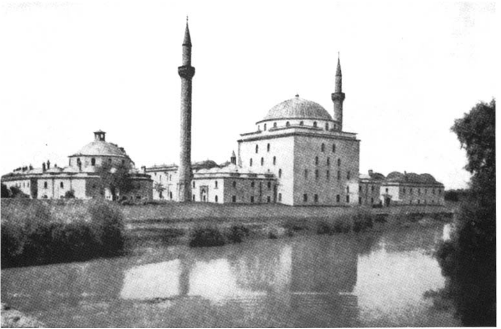
Mosquée de Bâyezid II et hôpital.
