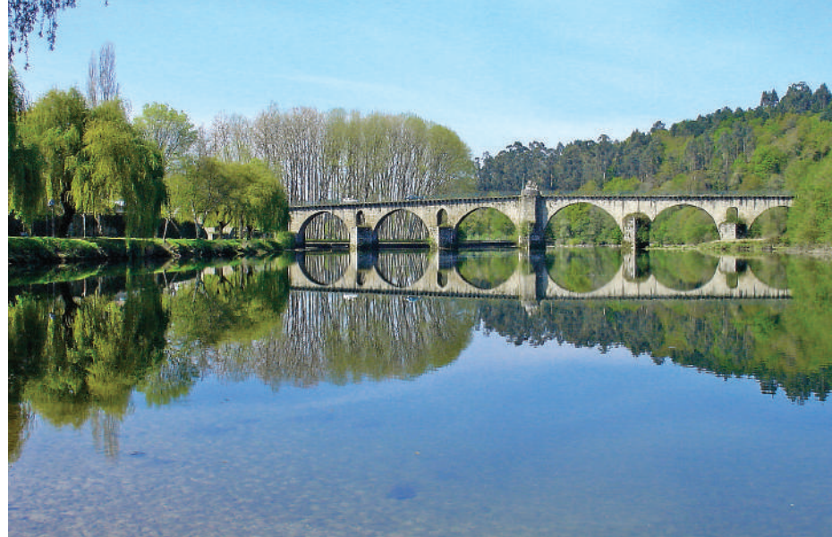
Ponte sobre o Lima – Ponte da Barca
