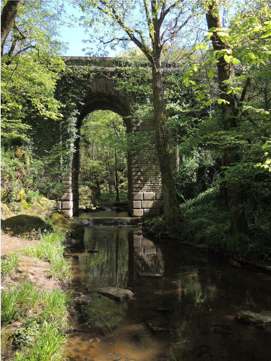
Le Pont du Déluge
