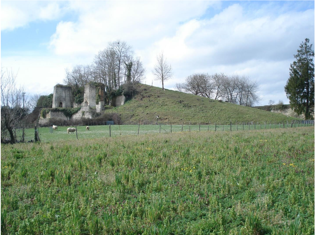
Vue d'ensemble des fours à chaux avec leur rampe d'alimentation
