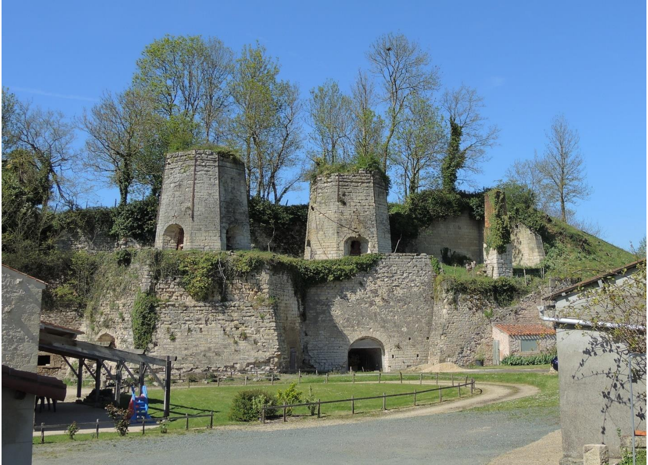
Vue d'ensemble des fours à chaux - Fourneaux à deux niveaux
