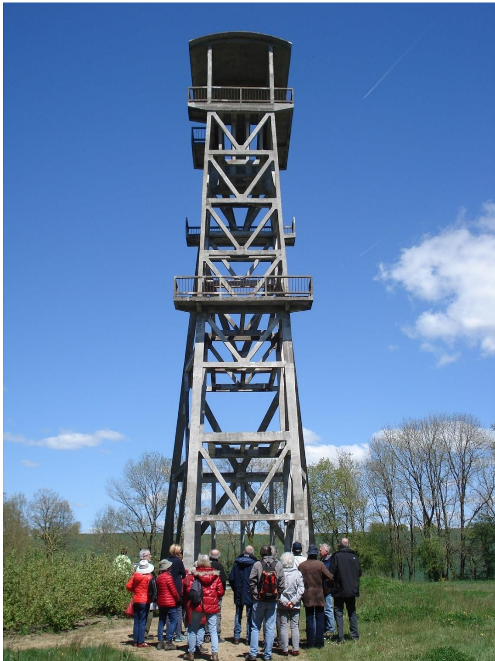
Le chevalement en béton du puits Saint-Michel
