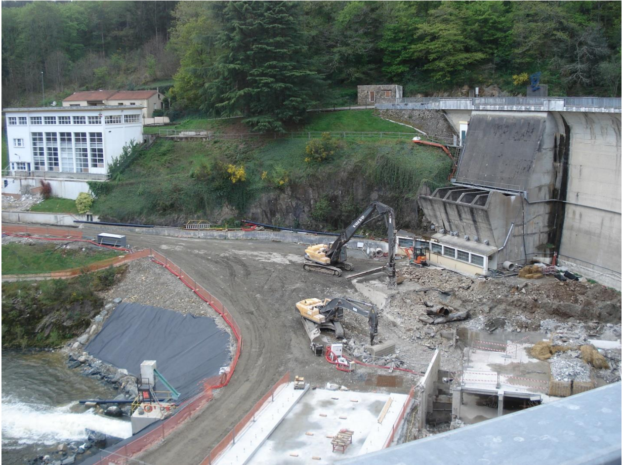
Le barrage de Mervent en travaux
