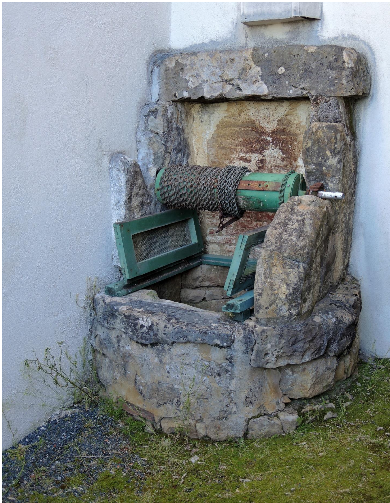
Puits fait en calcaire hettangien Au fond du puits, affleure le calcaire jurassique.
