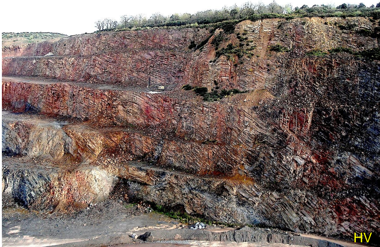
Photo 2 : Carrière de Vairé, paroi nord-ouest - 5 paliers de 15 m (HV)
