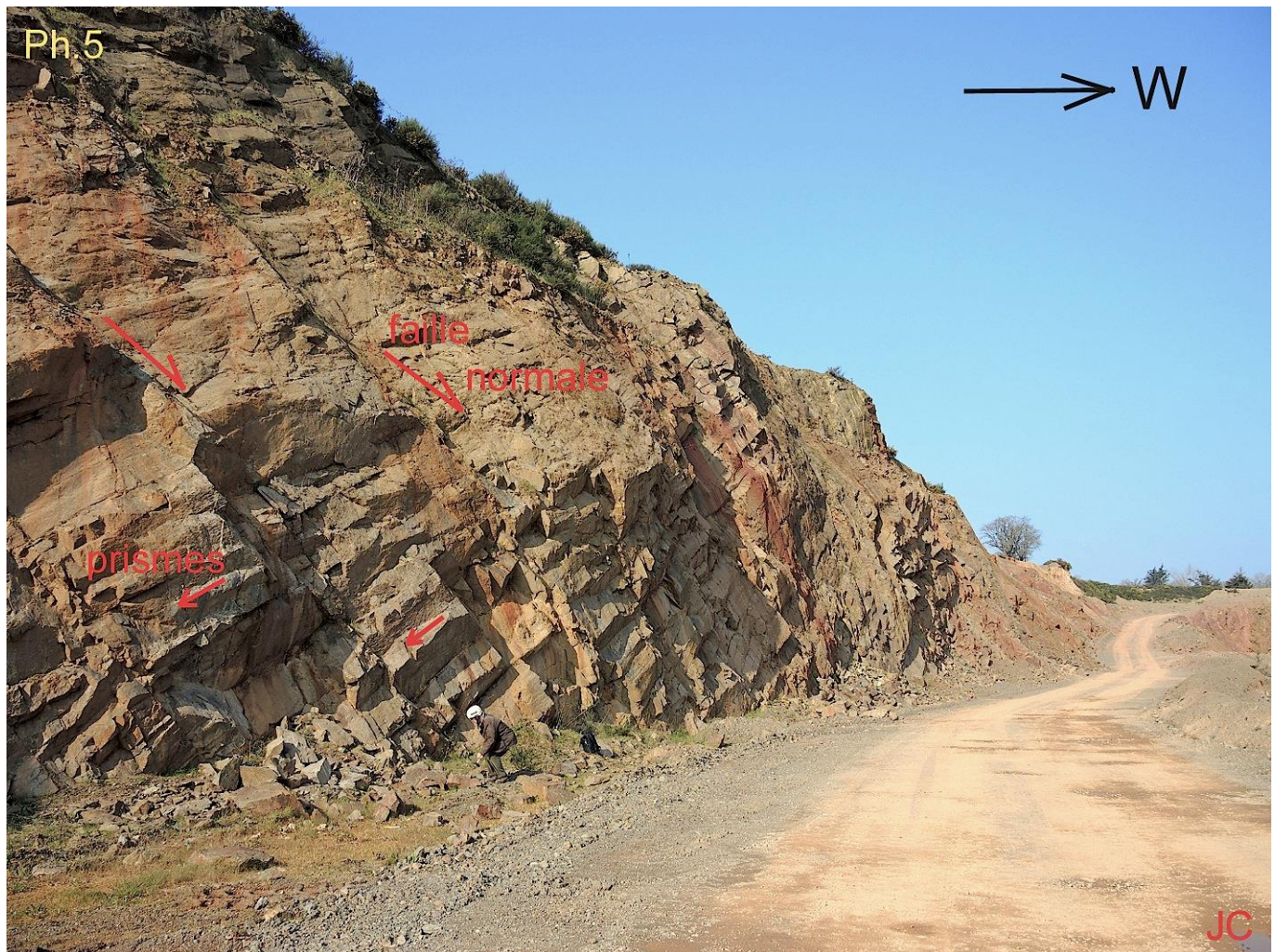
Photo 5 : Failles normales concentrées vers la bordure ouest du massif - Les prismes deviennent indistincts (JC)
