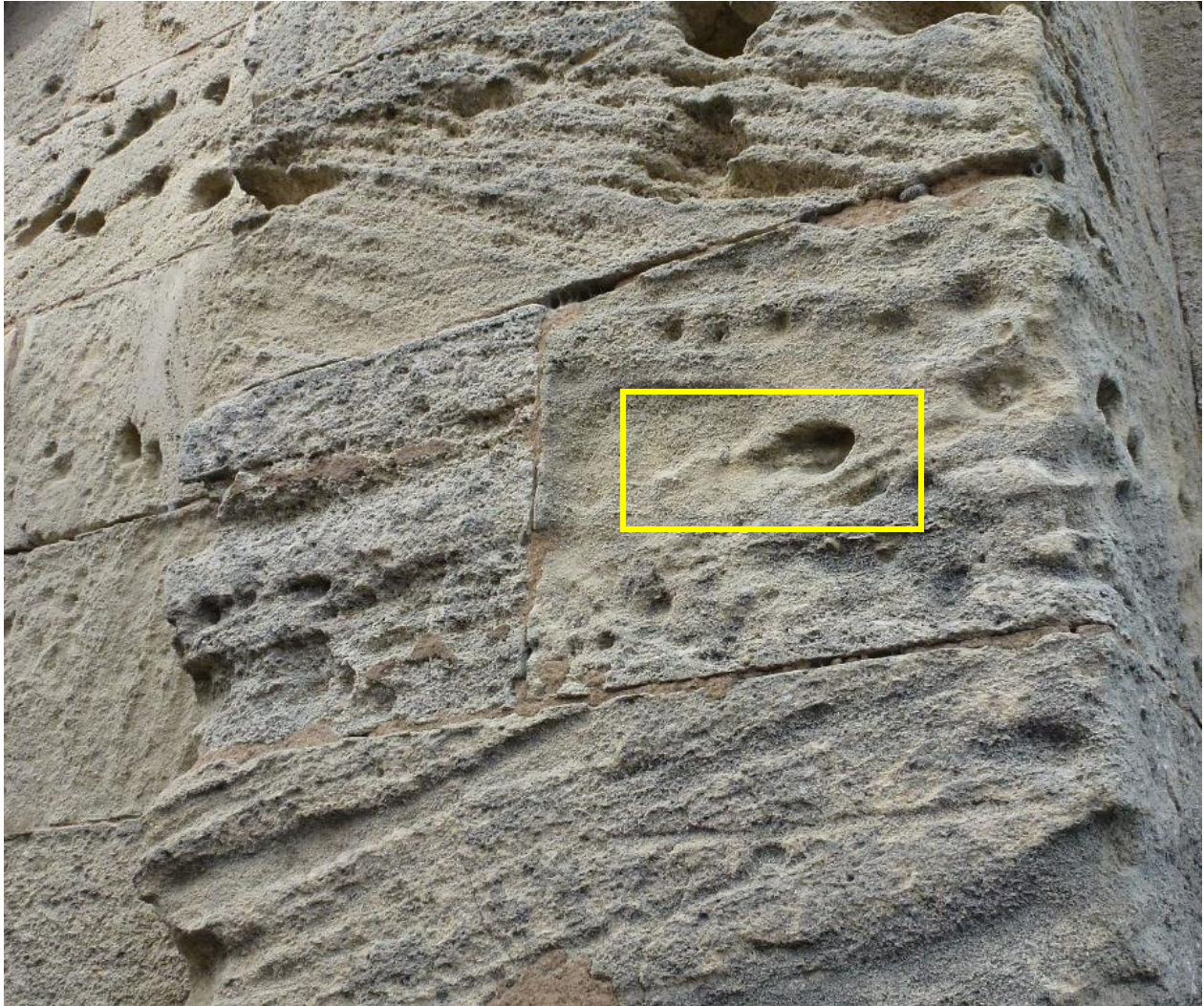
Figures de stratification oblique et entrecroisée et figures de charges (dans le cadre)
