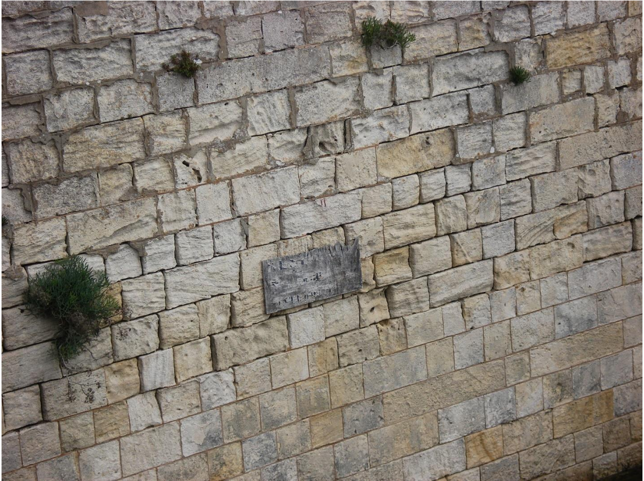
Détail du mur
