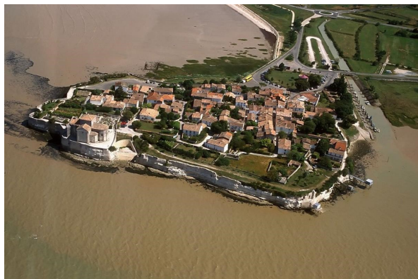
Vue aérienne de Talmont-sur-Gironde
