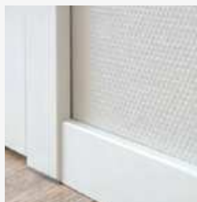
Zarge mit Bekleidungsstärke 18,5 mm
