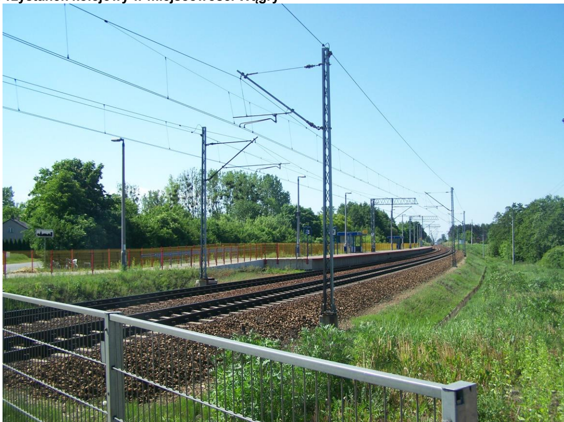
Fot. 10 Przystanek kolejowy w miejscowości Wąгры
