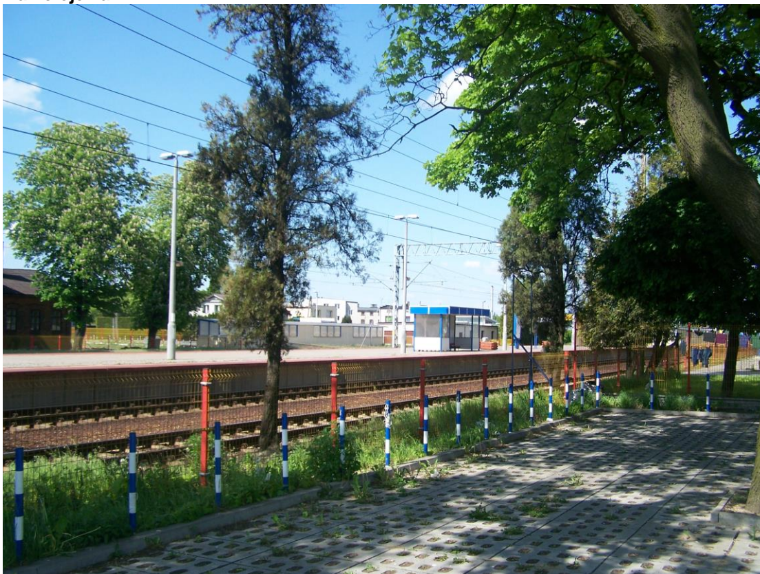
Fot. 9 Linia kolejowa
