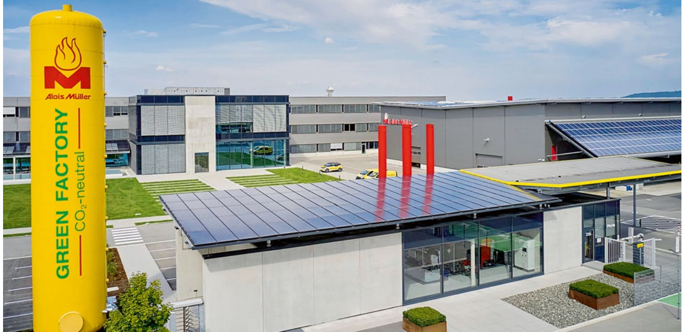
Dieser Neubau ist auf Energiegewinnung und die Speicherung ausgelegt. Das Konzept strahlt auch auf den Fuhrpark ab
