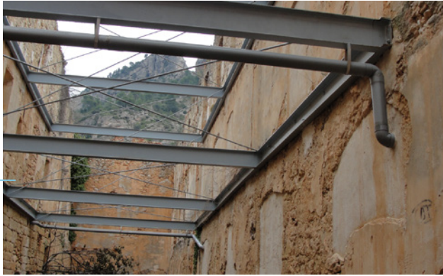
Tensors de l'ala sud. Suport de la paret del claustre. Foto: Consol Marcó
