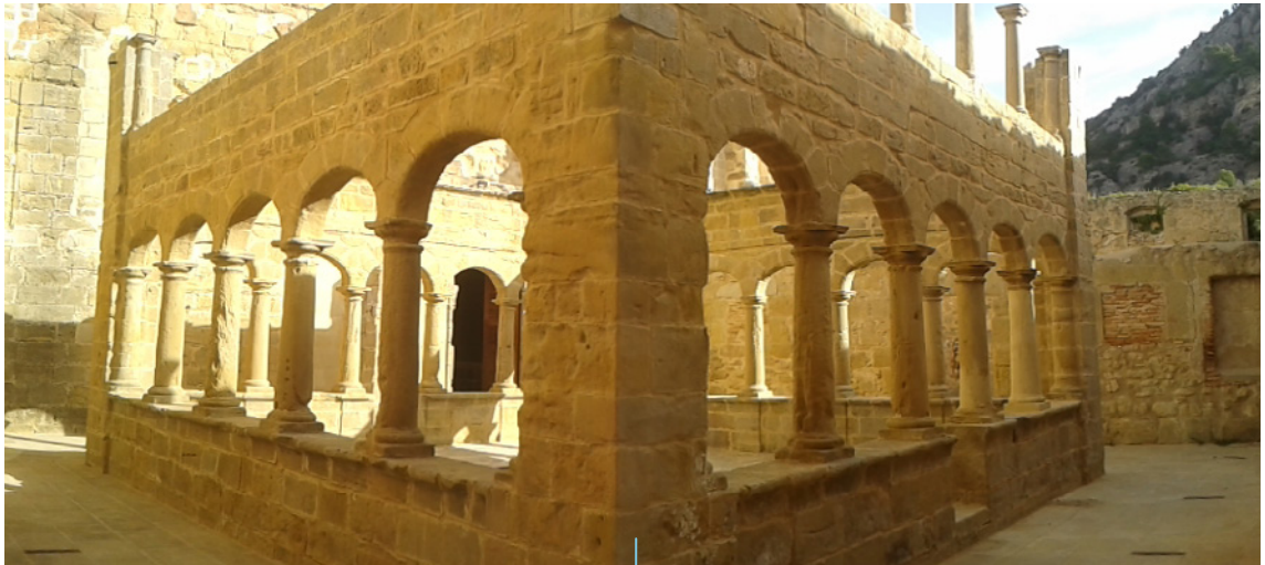
Restauració del claustre. Foto: Consol Marcó
