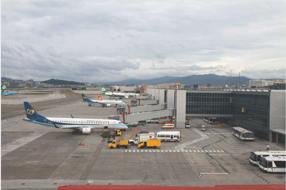
圖 07：臺北國際航空站停機坪。〈空橋及機坪〉。圖片提供者：交通部民用航空局臺北國際航空站。網站名稱：交通部民用航空局臺北國際航空站。
