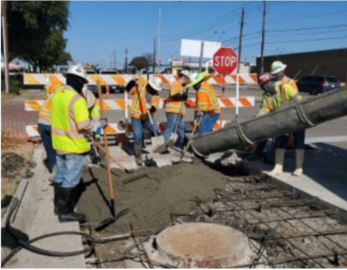
Paving pour after utility relocation
