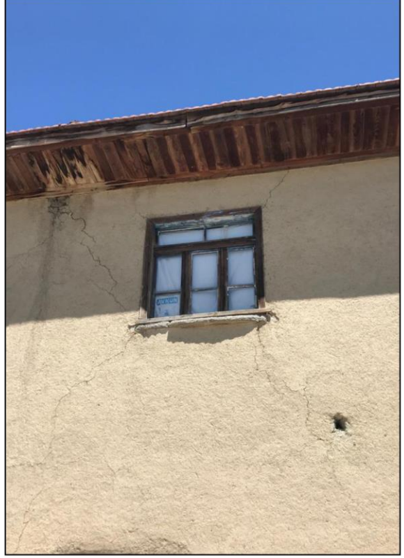
Şekil 4. Dutluca Mahallesinde deprem nedeniyle oluşan hasarlar
