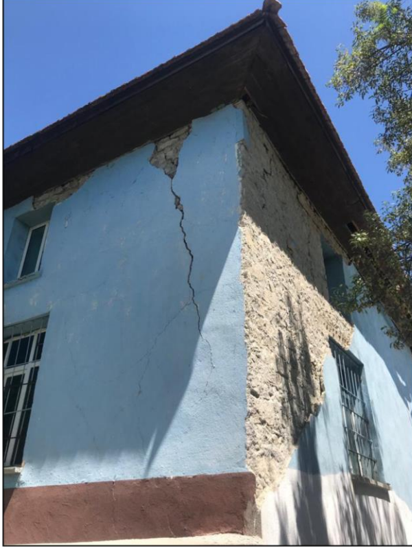
Şekil 4. Dutluca Mahallesinde deprem nedeniyle oluşan hasarlar
