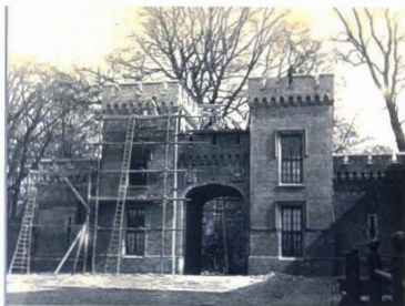
De cementering van het poortgebouw werd na een strenge winter in 1916 verwijderd.
