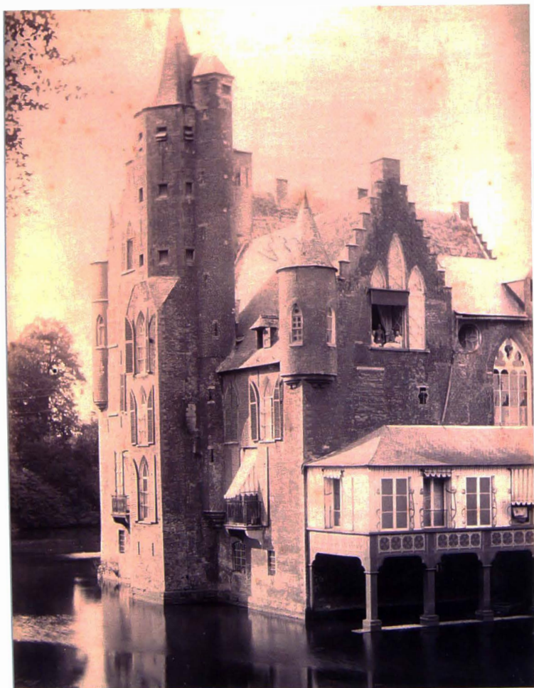
De houten aanbouw tegen de oostgevel in 1885
