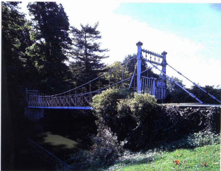
IJzeren hangbrug in het kasteelpark
