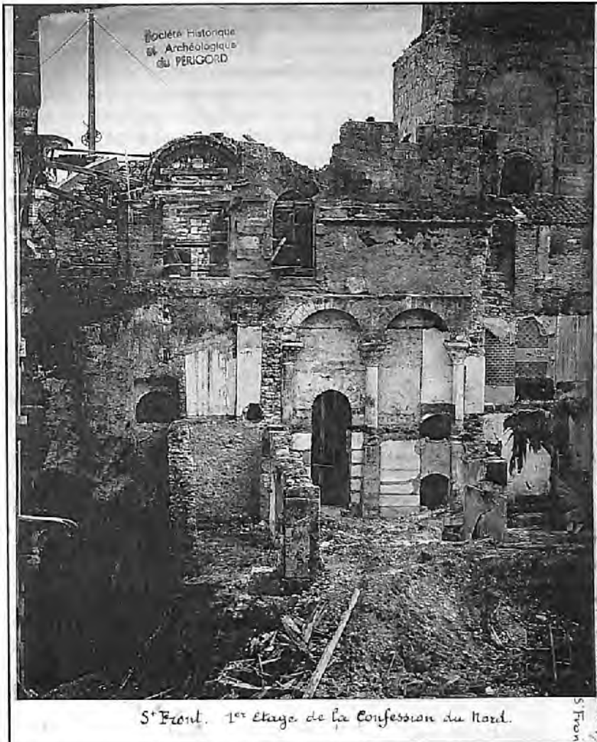
Saint-Front. Premier étage de la confession Nord.
