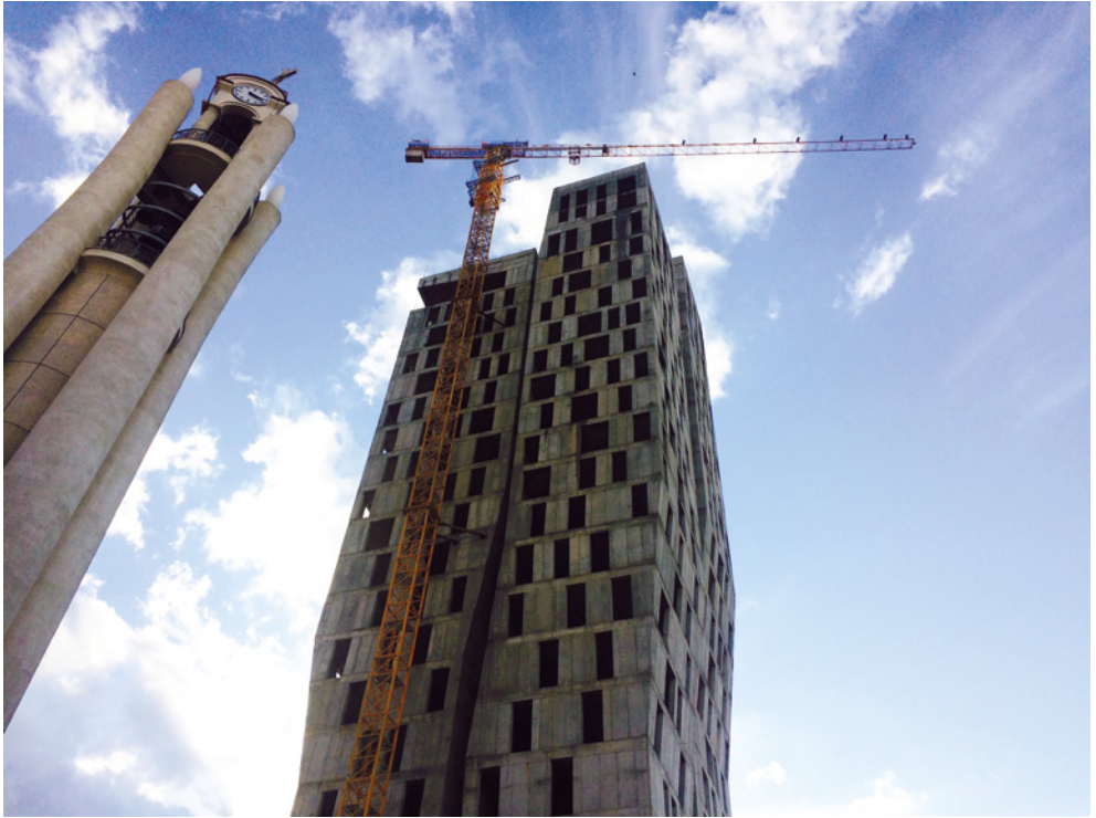
La 4 Ever Green Tower in costruzione (2018; progetto Studio Archa, Firenze) e il campanile della Nuova Cattedrale Ortodossa a Tirana, Albania (foto: Margherita Fochessati)
