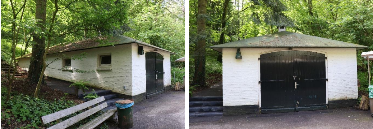
Afbeelding 14 & 15: De berging gezien in zuidoostelijke richting en de kopgevel met schuurdeuren
