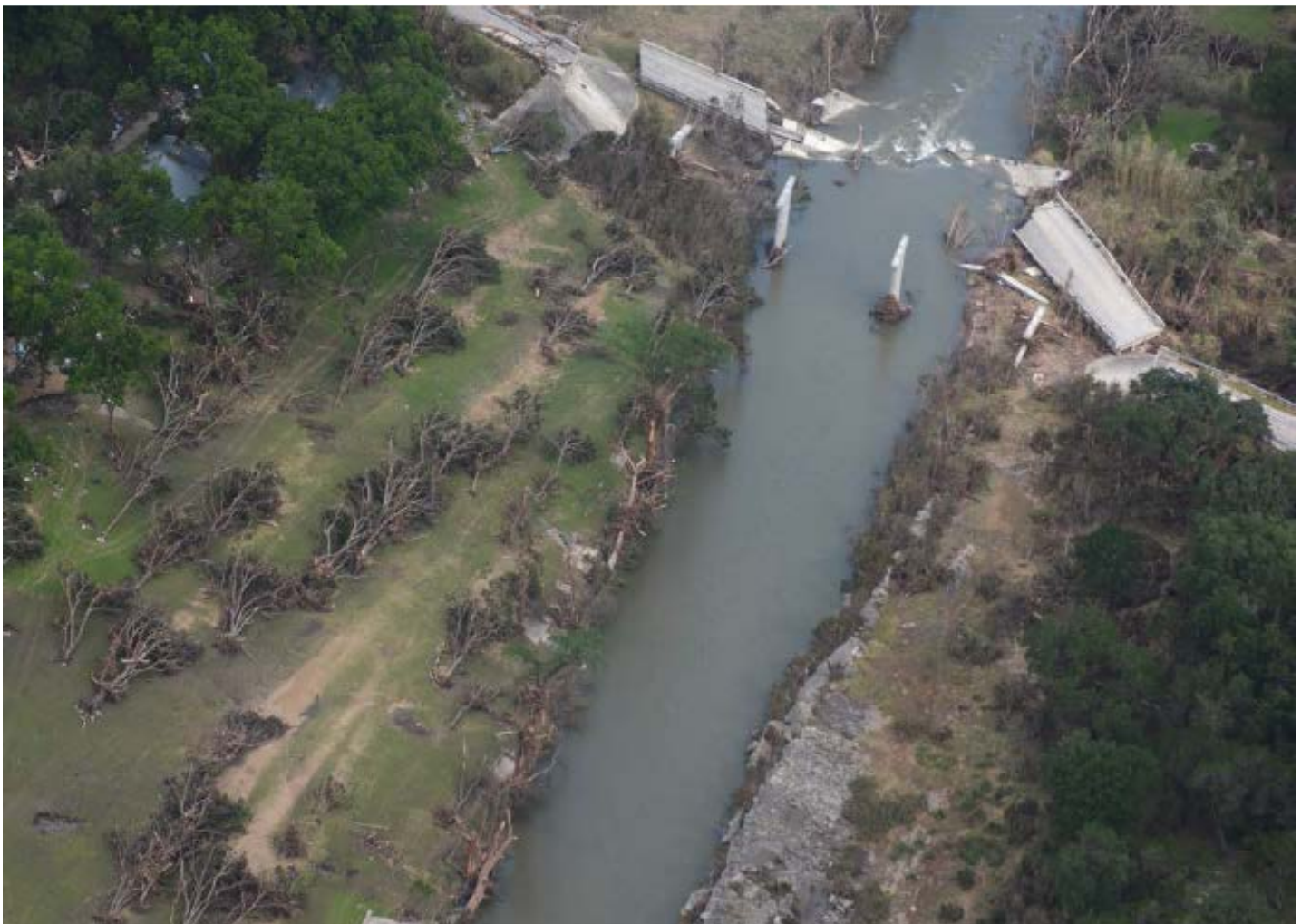
Puente de Fischer Store Road en el Condado de Hays
