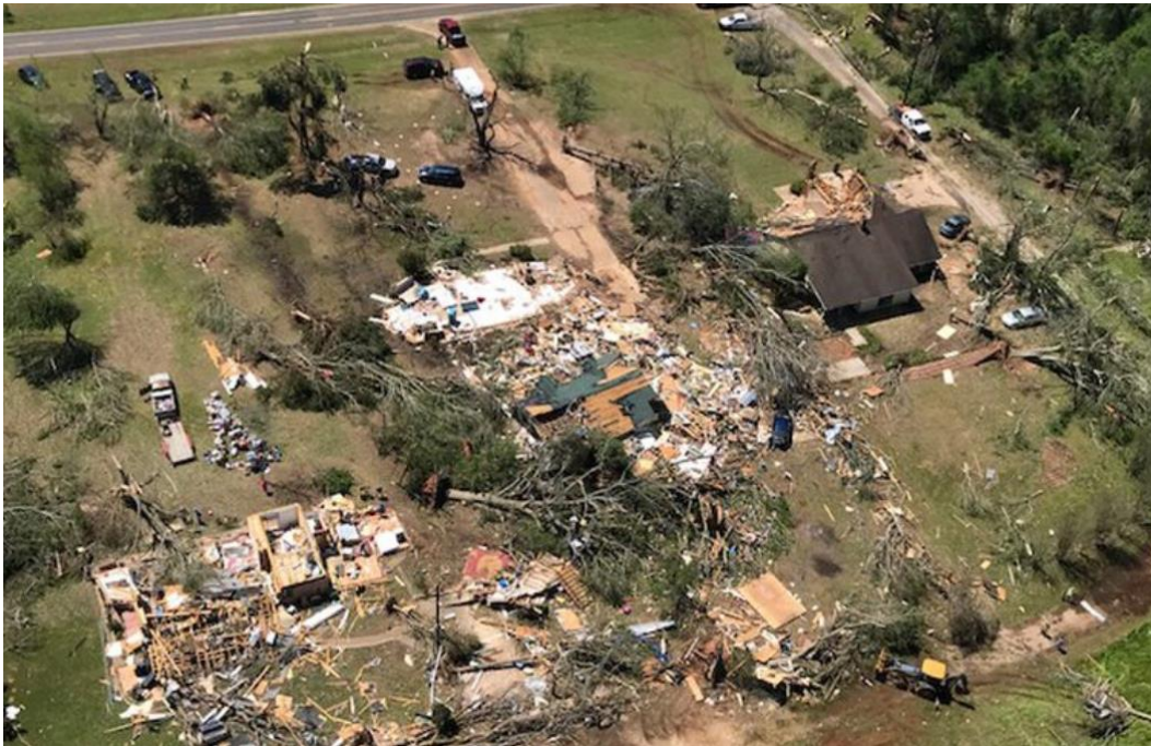
그림 0-46: 2019년 4월에 발생한 토네이도로 인한 체로키 카운티 주거지역 피해. 234
