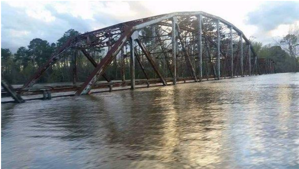
그림 3-4: 사빈 강 위 Burr's Ferry Bridge SH 63. 11
