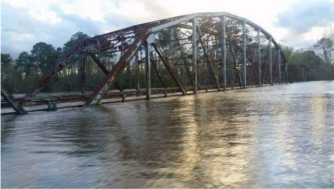
그림 3-4: 사빈 강 위 Burr's Ferry Bridge SH 63. 11
