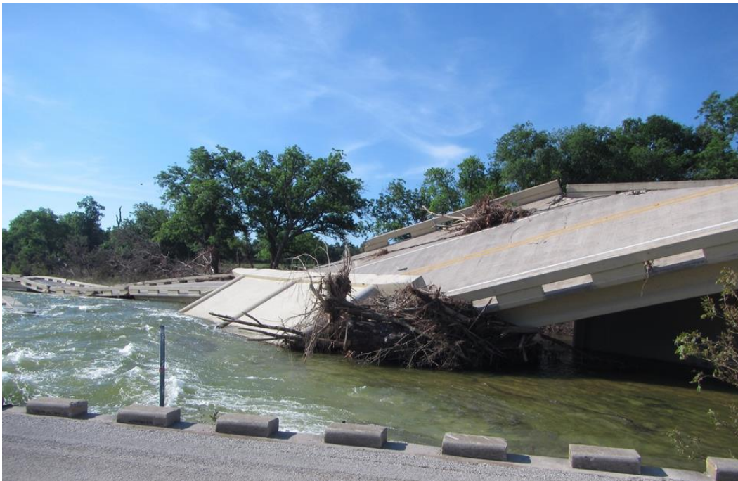
그림 3-1: 블랑코 강 위 Fischer Store Road Bridge. 4
