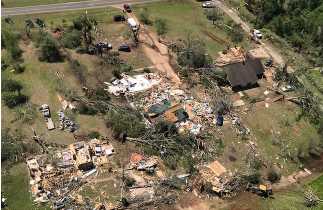
Hình 3-48: Khu dân cư ở Quận Cherokee chịu thiệt hại do lốc xoáy, tháng 4/2019. 234
