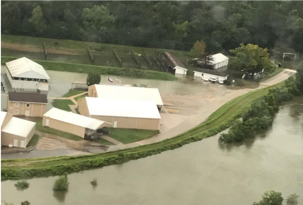
Hình 3-29: Nhà máy xử lý nước thải của thành phố Conroe trong Siêu bão Harvey. 85
