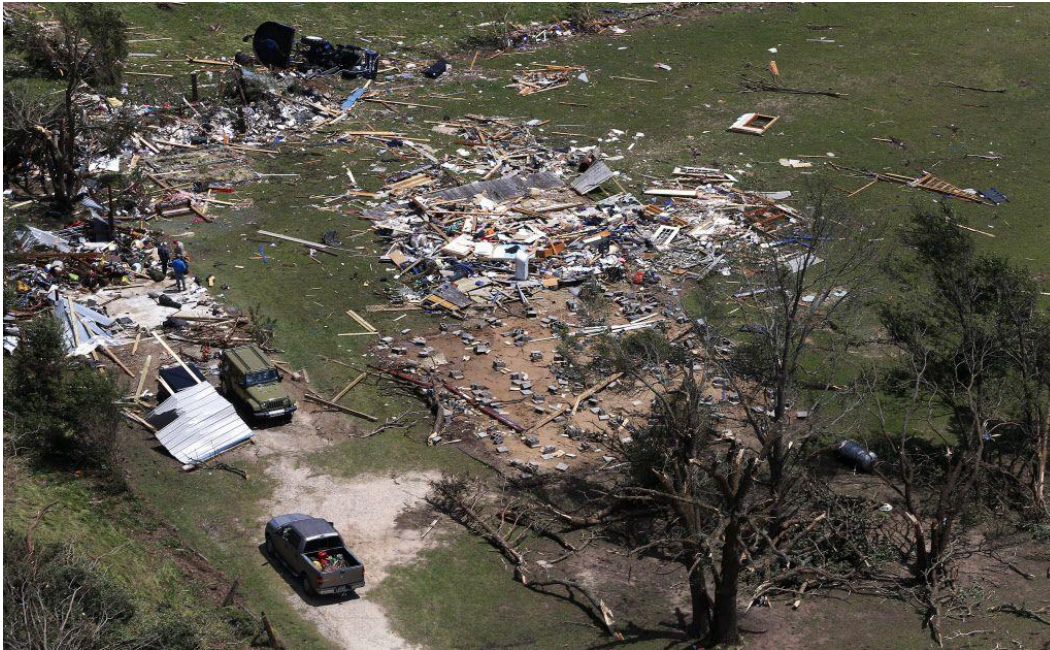
그림 0-47: 2017년 4월에 발생한 토네이도로 파괴된 캔턴의 주택. 237
