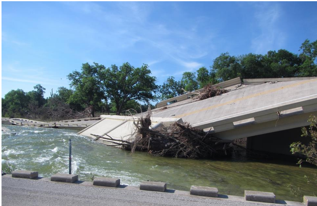
그림 3-1: 블랑코 강 위 Fischer Store Road Bridge. 4
