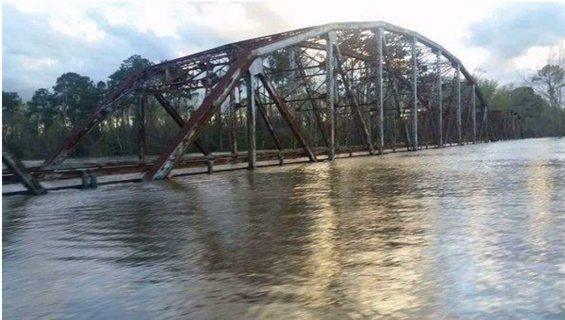
그림 3-4: 사빈 강 위 Burr's Ferry Bridge SH 63. 11
