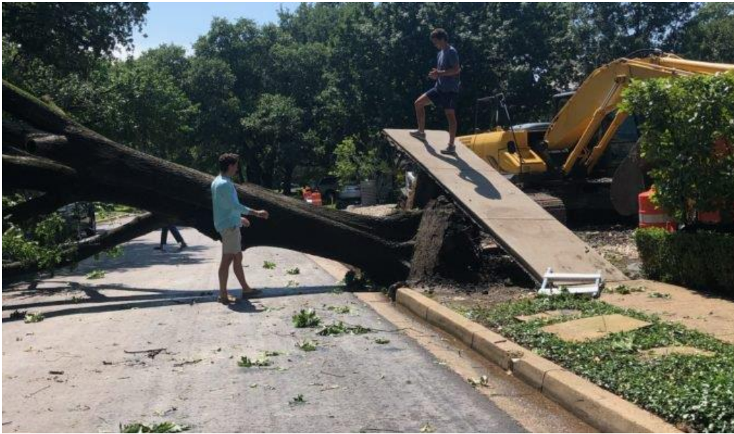
그림 0-50: 2019년 6월의 폭풍우를 동반한 열풍 발생 후 달라스의 뿌리 채 뽑힌 나무- 훼손된 보도 인프라 및 봉쇄된 차도. 253
