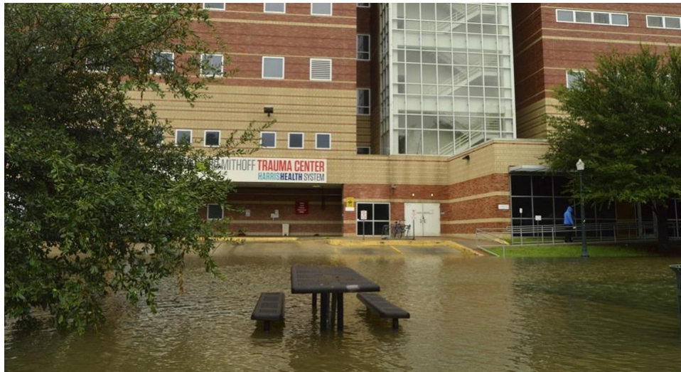
Hình 3-31: Nước lũ Siêu bão Harvey bao vây Bệnh viện Ben Taub ở Houston. 115
