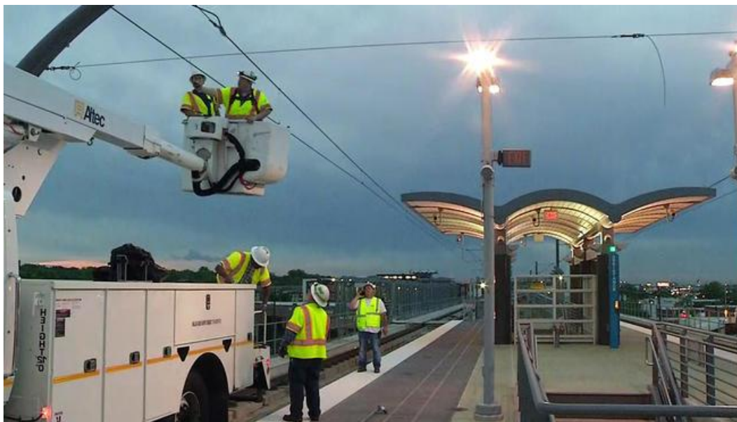
Hình 3-62: Đội bảo trì đang sửa chữa tuyến đường ray Carrollton DART bị hư hại do sét đánh. 345
