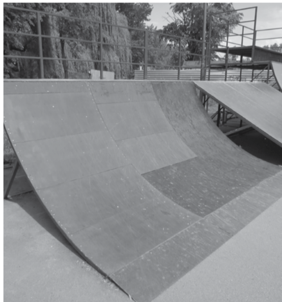
Пошкоджену фанеру замінили на нову
