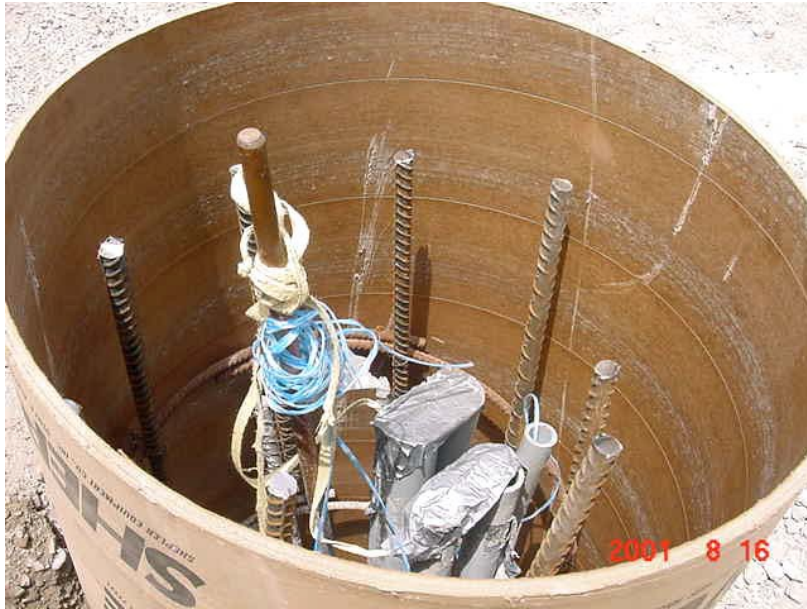
REBAR, ELECTRICAL CONDUIT
