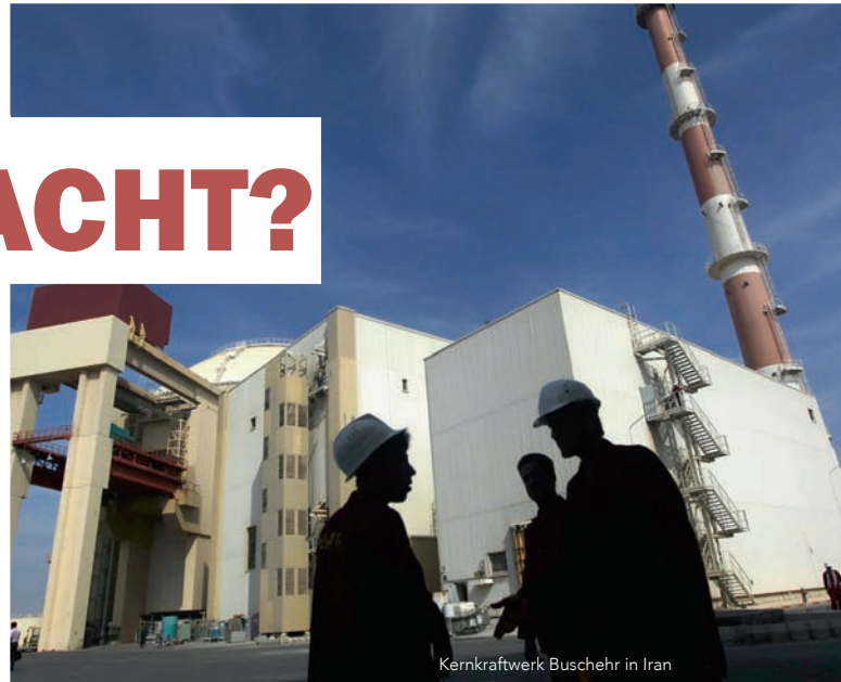
Kernkraftwerk Buschehr in Iran
