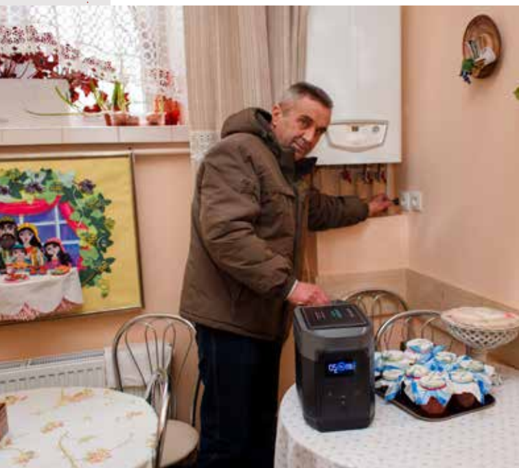
Batteriespeicher für autarke Stromversorgung
