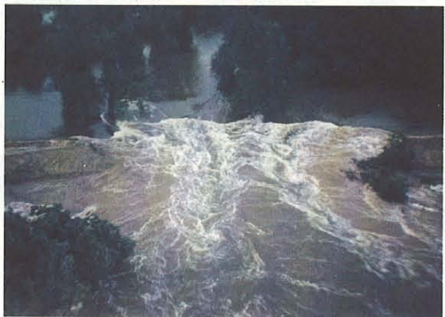
Abb. 2.2-2: Oderdeichbruch bei Aurith am 24.07.1997
